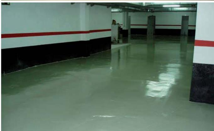
Aplicaciones Químicas Insulares recibe el encargo de impermeabilizar y pavimentar un garaje de un edificio de viviendas de nueva construcción cerca del mar en Fuerteventura. Cuando la empresa aplicadora acude a la obra se encuentra con una losa bajo el nivel freático inundada parcialmente por el agua del mar.
