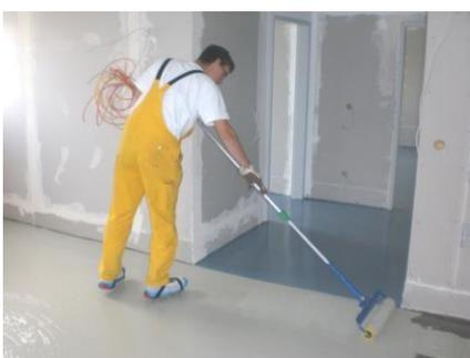
El producto tixotrópico Sikafloor® se tiene que aplicar mediante pasadas en dos direcciones perpendiculares con un rodillo de texturar, con el fin de generar una superficie de textura de piel de naranja
