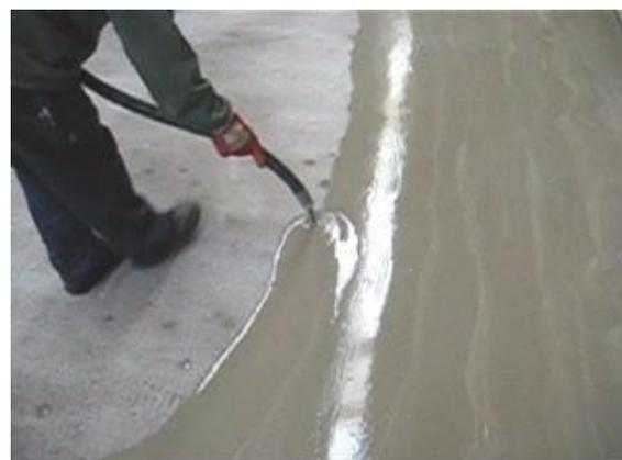
El producto se coloca mientras se va caminando a lo largo del frente de vertido y manteniendo el "borde húmedo", es decir, colocando siempre el producto sobre el material previamente colocado antes de que comience a secarse (volviéndose mate) y de que endurezca.
