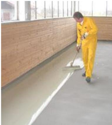
El material se vierte, se extiende uniformemente con una llana dentada, ya sea de pie o de rodillas. Para una mejor nivelación pasar el rodillo de púas inmediatamente en dos direcciones para nivelar y eliminar el aire ocluido. Asegúrese de que el espolvoreo se realiza de forma uniforme, sin dejar zonas sin cubrir. El material debe ser esparcido en exceso, sin dejar zonas sin o con menor cantidad de árido.
