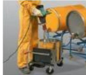
Transferir la resina Sikafloor® ya mezclada a un recipiente limpio y mezclar durante un minuto más. El carro tiene frenos bloqueables en las ruedas que permiten facilitar la mezcla.
