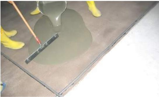
Verter el material mezclado sobre la superficie imprimada y extenderlo con llana o rastrillo al espesor requerido.
