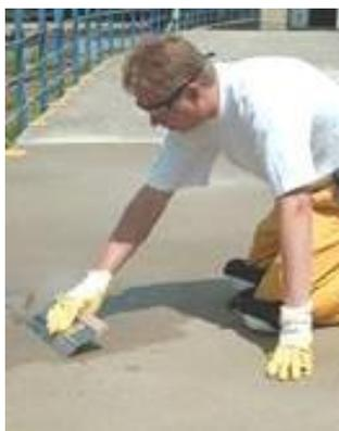
La aplicación de la capa de adherencia con llana de goma/acero hasta el espesor requerido - de rodillas o de pie.
