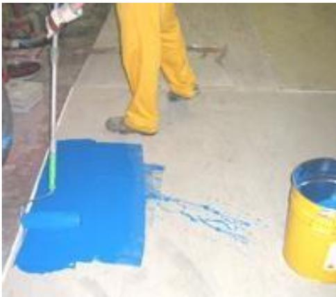
El producto se aplica como revestimiento por medio de rodillo o como una capa de sellado por con llana de goma y luego extendidas en dos pasadas (en perpendicular) con un rodillo de pelo corto
