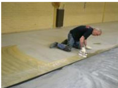
El Sikafloor® Comfort Adhesive se debe verter y extender uniformemente por medio de una llana dentada, de rodillas.
