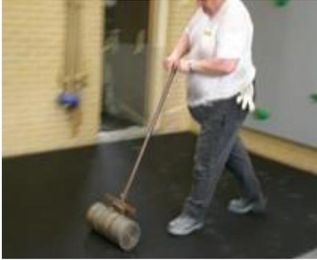
Presionar hacia abajo la shockpad con un rodillo pesado mientras el adhesivo está aún fresco
