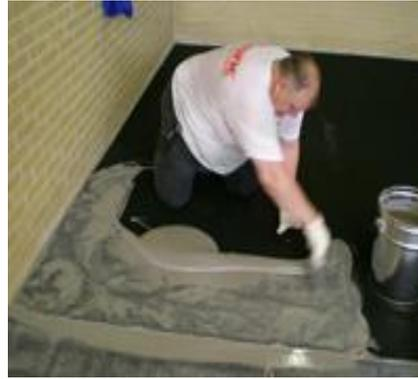
El Sikafloor® - Comfort Porfillers se debe verter y extender uniformemente por medio de una llana dentada, de rodillas.
