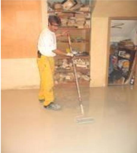
Pasar el rodillo de púas inmediatamente en dos direcciones (perpendiculares) para asegurar un espesor uniforme y para eliminar el aire atrapado.
