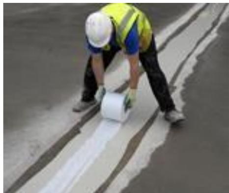
Después de la aplicación de Sikafloor®-15 Pronto, desenrollar Sikalastic®-120 Fleece sobre la resina húmeda, presionando hasta eliminar el aire atrapado usando un rodillo de lana, asegurando un solape mínimo de 50 mm entre las láminas de refuerzo. Aplicar, "húmedo sobre húmedo", una capa de encapsulación de Sikafloor® -15 Pronto usando un rodillo de lana para garantizar la plena saturación
