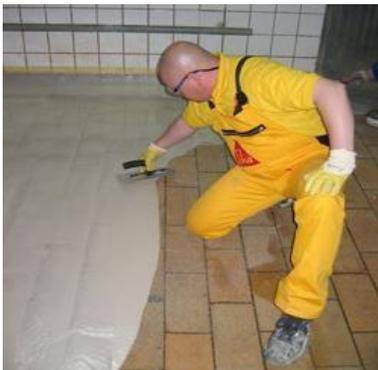
Después de la adecuada preparación de la superficie, asegurarse de que una capa continua, sin poros cubre el soporte. Si es necesario, aplicar dos capas de imprimación.
