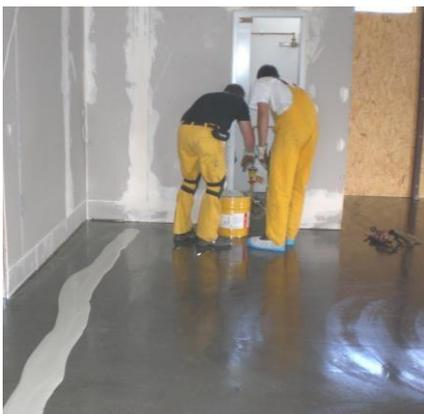
El material de Sikafloor®-se vierte y extiende uniformemente por medio de una llana dentada, ya sea de pie o de rodillas.
