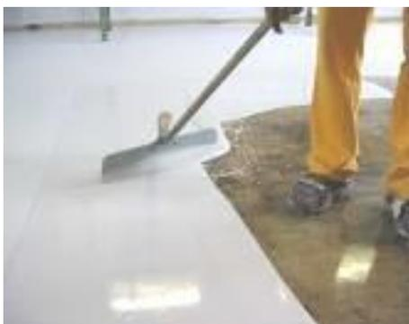
El producto se debe verter y extender uniformemente por medio de una llana dentada, ya sea de pie o de rodillas. Después de extender el material de manera uniforme, girar la llana dentada y alisar la superficie con el fin de lograr un grado más alto de acabado estético.
