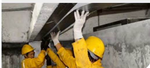
REHABILITACIÓN DE ESTRUCTURAS
