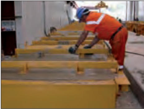
Foto 27.- Fratasado de dovela base. Acopio de dovelas
