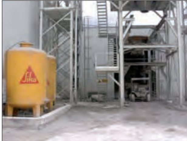
Foto 30.- Planta de hormigón de dovelas en los túneles de Pajares
