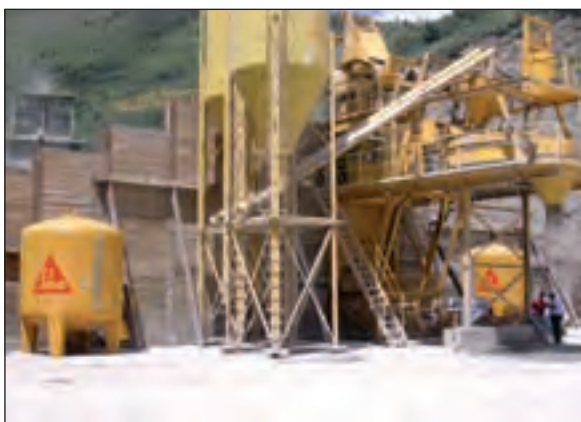
Foto 6.- Detalle de una planta de hormigón de obra
