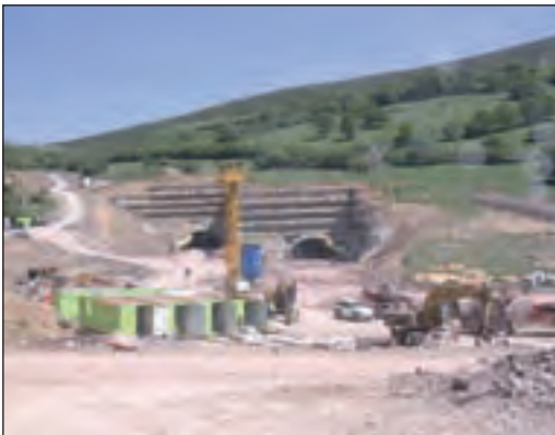
Foto 1.- Emboquille convencional complejo y montaje de TBM
