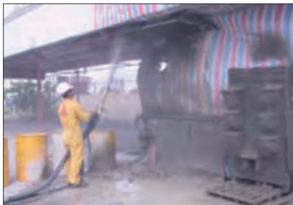
Foto 5.- Ensayos previos de adherencia sobre paneles
