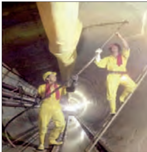
Foto 17.- Labores de inyección en un túnel
