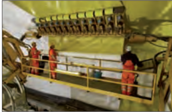
Foto 20.- Colocación de lamina de PVC-P en un túnel
