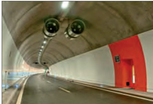
Foto 9.- Hormigón de revestimiento de túnel terminado
