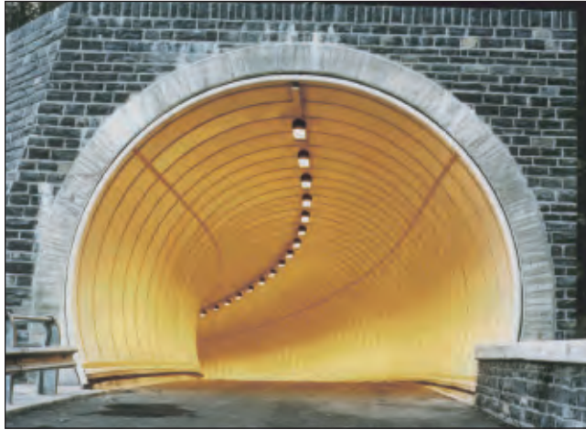
Foto 11.- Emboquille de un túnel revestido con paneles
