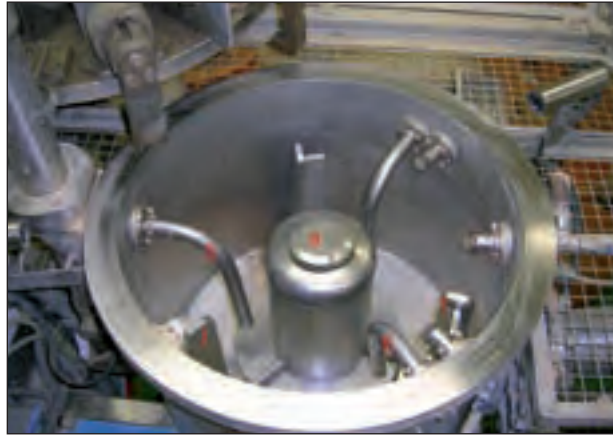
Foto 33.- Detalle de la cámara de mezclado y componentes
