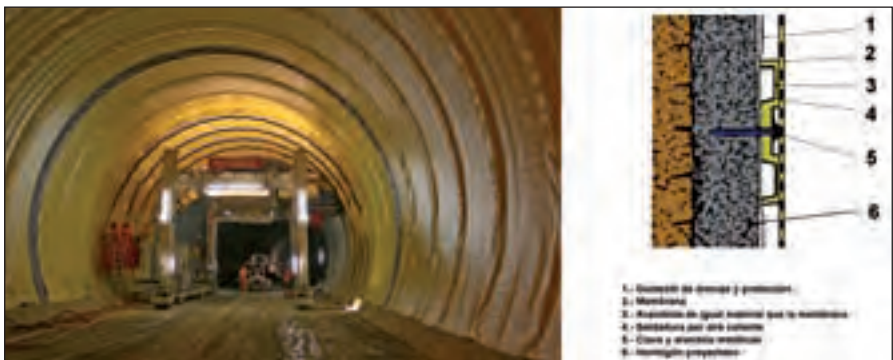
Foto 18.- Lámina de PVC colocada en un túnel y detalle del anclaje de la lámina
