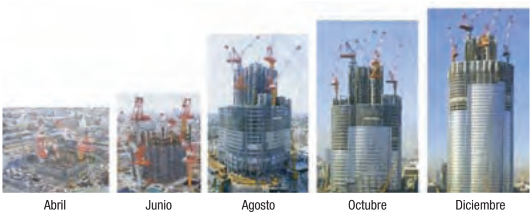
Foto 40.- Secuencia de construcción del edificio con SCC
