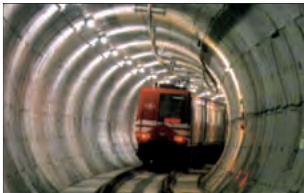
Foto 10.- Revestimiento de tunnel con dovelas prefabricadas
