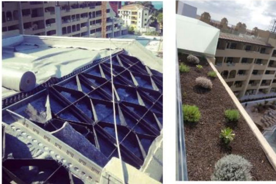
Fotos instalación de las cubiertas planas
