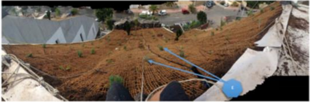
Instalación de los elementos que componen la cubierta ajardinada inclinada
