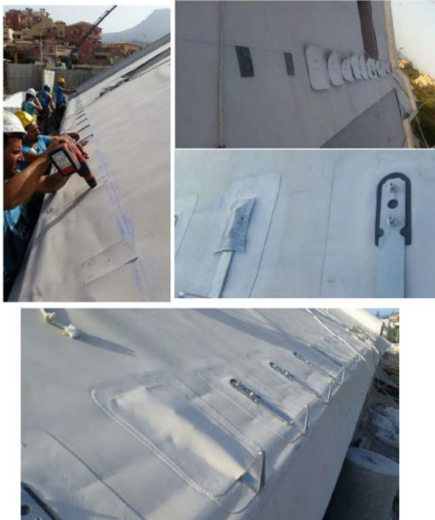
Instalación de elementos antiempuje Zinco LF-300. Impermeabilizado con lámina Sarnafil TG 66-18
