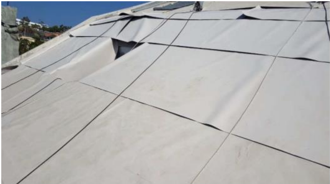
Cubierta ajardinada con pendientes variables, Instalación de la lámina SARNAFIL TG 66-18.
