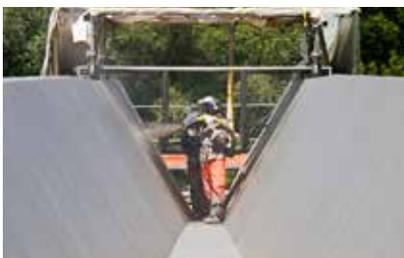
Sikalastic<sup>®</sup> - 851 R membrana líquida proyectable de dos componentes
