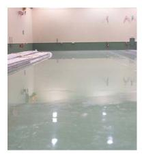
Inicialmente otra opción que se barajó para cumplir la alta planimetría fue la de colocar sucesivas capas de algún sistema autonivelante, pero finalmente se adoptó por un sistema con mortero seco. Esta elección fue acertada, ya que durante la ejecución se llegaron a observar espesores de hasta 5 cm. y espesores mínimos de 3 mm. Con un sistema autonivelante la ejecución habría sido bastante problemática.
