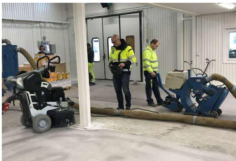
Preparación del soporte: Limpieza por chorreo de arena u otros medios mecánicos. P.ej. Blastrac, HTC o similar.
