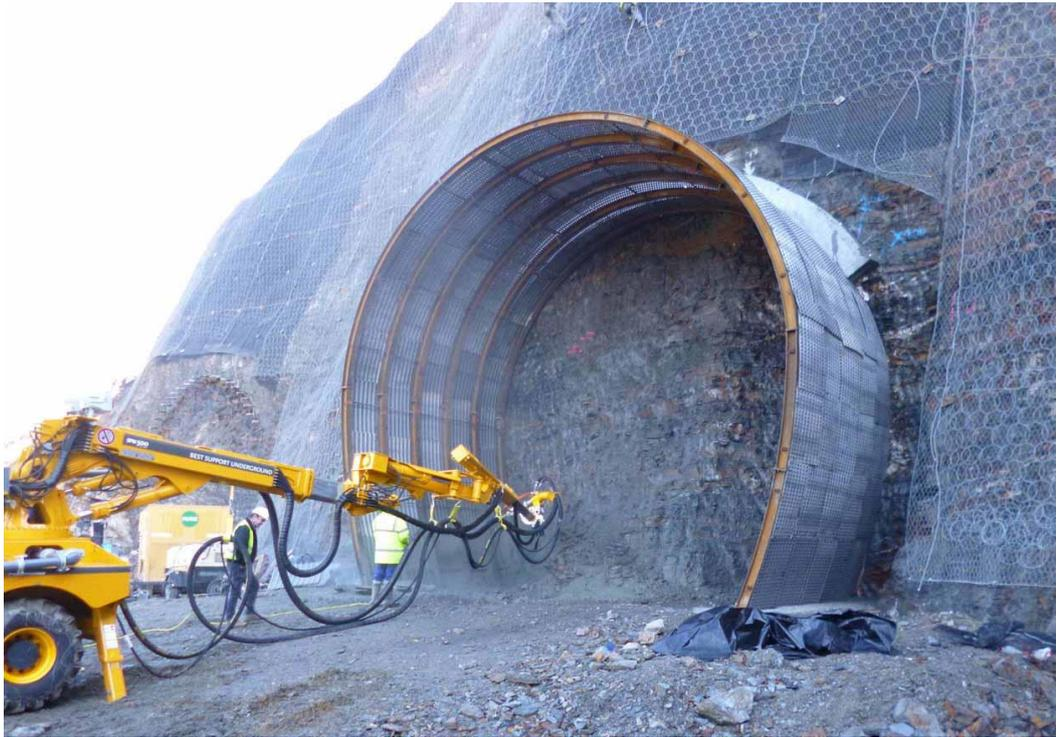
Sika ha suministrado en esta obra uno de los mayores contratos de impermeabilización del tramo AVE Zamora – Orense, en el túnel de Prado en su vía derecha, con la lámina de impermeabilización a base de pvc, especial para su utilización en túneles Sikaplan WP-1100-20HL, también utilizada en el emblemático y acabado hace un par de años, Túnel de San Gotardo en Suiza.
