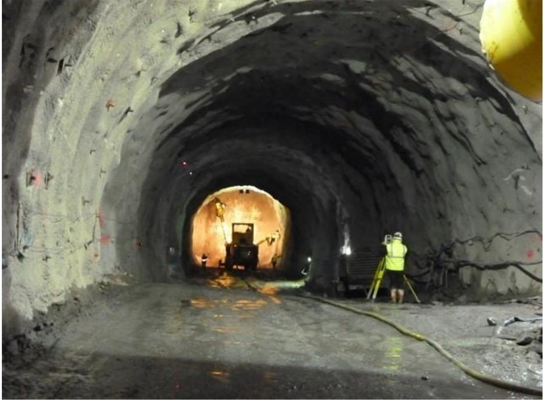
En las bocas de los dos tubos se sitúan, entre ambas vías, zonas de rescate. Además, existen galerías de emergencia de conexión y galerías de servicio entre ambos tubos. Ambos túneles comparten características, como una sección libre de 52 metros cuadrados; el radio mínimo de curva, que es de 7.250 metros y una pendiente longitudinal variable que va de 20,7 a 2 milésimas.
