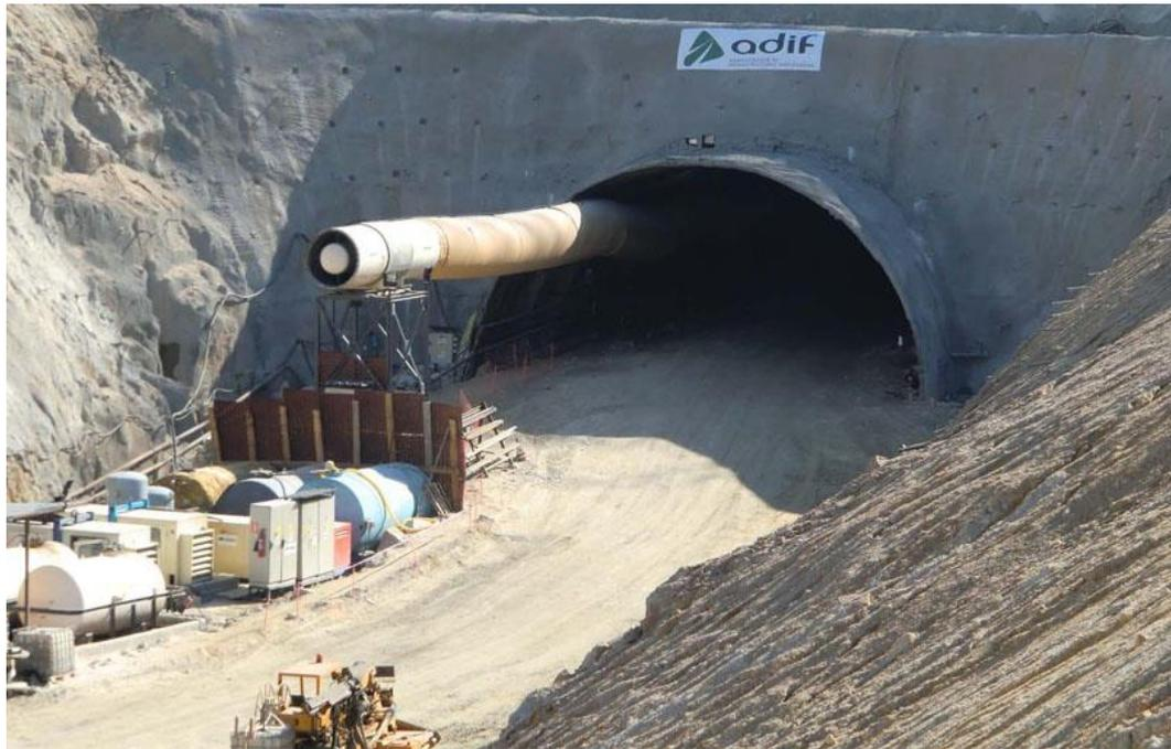
El túnel de Bouzas tiene 852 metros de longitud, de los cuales 676,11 han sido excavados en mina y 175,95 adoptan la morfología de túnel artificial en ambas bocas, mediante estructuras abovedadas de hormigón armado, con el fin de mejorar la integración de la infraestructura en las laderas.
