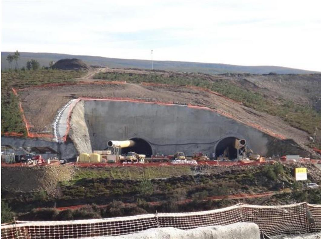
El túnel dispondrá igualmente de galerías transversales de emergencia que conectarán ambos tubos cada cuatrocientos metros como intervalo máximo. Desde la boca oeste se ha planteado como método de construcción el de avance y destroza.
