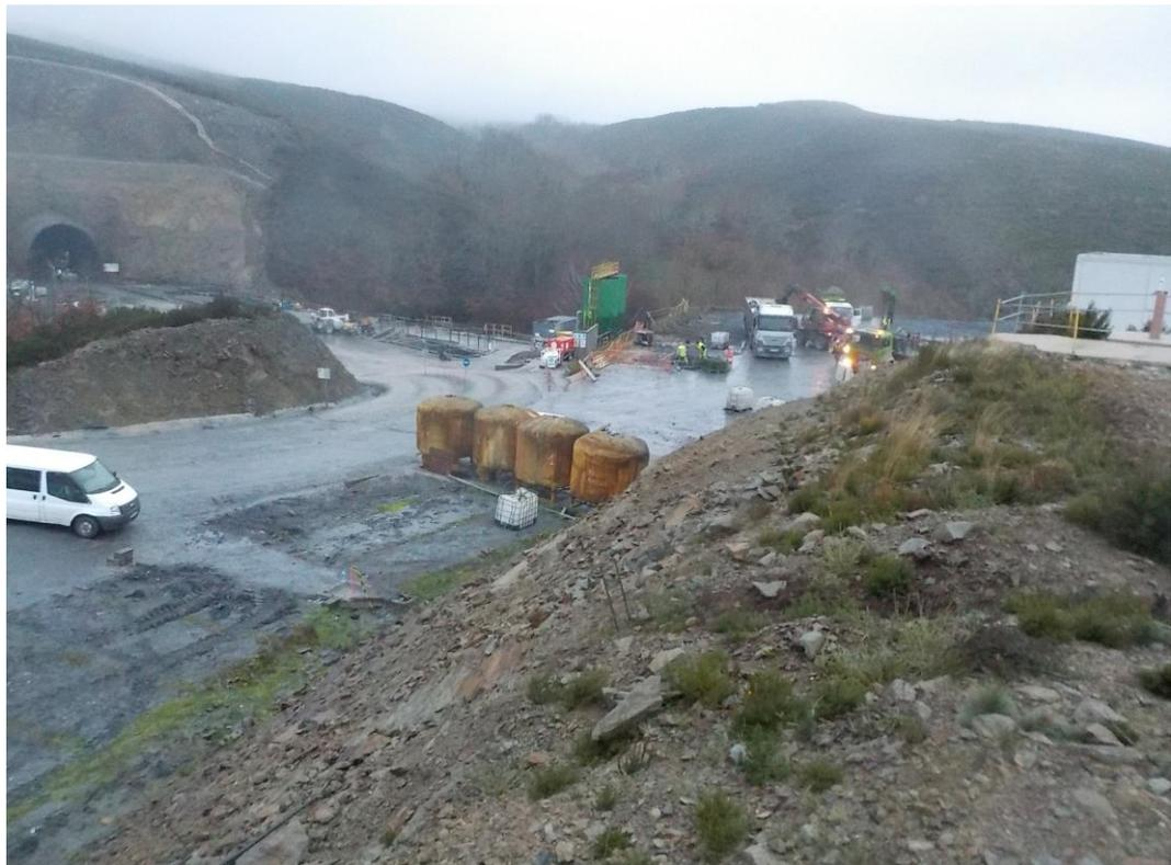
El túnel de O Espiño se ha construido por medios convencionales, y además de por ambas bocas, se realizó una galería intermedia de acceso, para excavar desde dicha galería de acceso hacia ambos emboquilles con el fin de acortar los plazos de ejecución del túnel, el cual es el segundo más largo de toda la línea del AVE Zamora – Orense.
