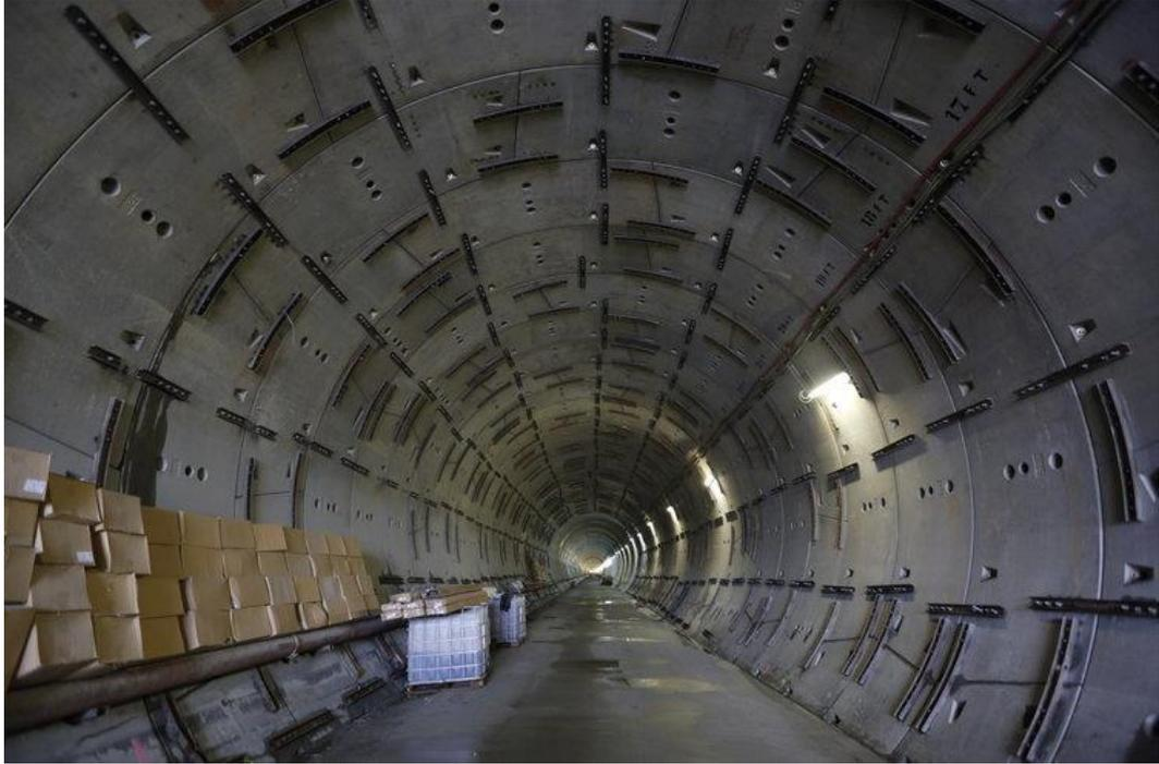
Una vez pasada la localidad de Campobeceros, se inicia el siguiente túnel bitubo del tramo, los túneles de Portocamba, de 3750 m en su vía izquierda, y 3680 m en su vía derecha. Ambos tubos fueron realizados mediante el NATM de excavación de túneles, con secciones de avance y destroza, y posterior impermeabilización y revestimiento de hormigón de los túneles.
