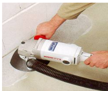
Preparación soporte: fresado
