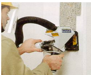
Preparación soporte: granallado
