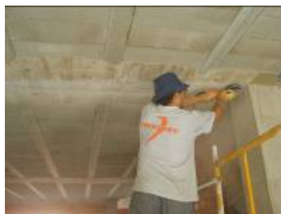
Preparación soporte: lijadora con disco de diamante
