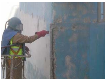
Preparación soporte: chorro de arena
