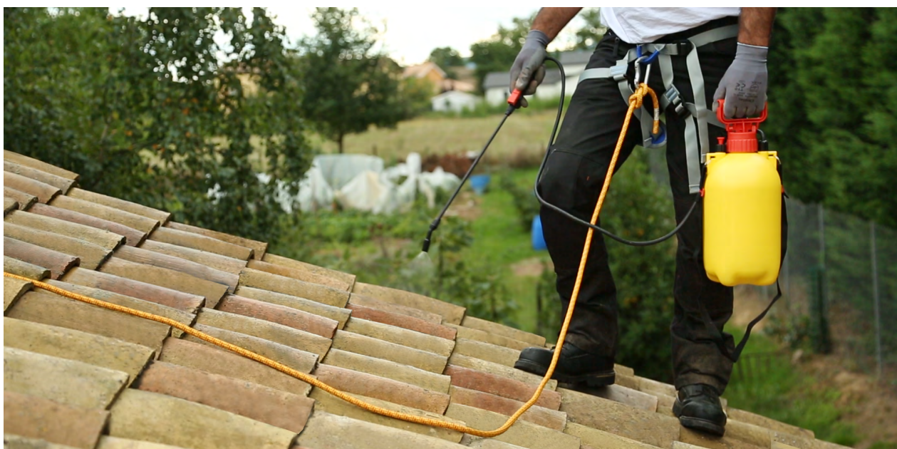
Primero raspe y cepille las superficies limpias para obtener el máximo rendimiento del producto. Aplique Sika® Stop Green y deje actuar.
