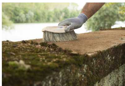
Primero raspe y cepille las superficies limpias para obtener el máximo rendimiento del producto. Aplique Sika® Stop Green y deje actuar.
