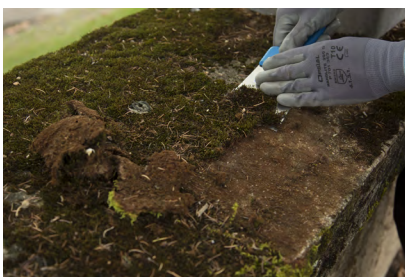
Primero raspe y cepille las superficies limpias para obtener el máximo rendimiento del producto. Aplique Sika® Stop Green y deje actuar.
