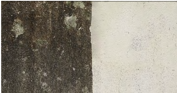
Fachada antes de la limpieza.
