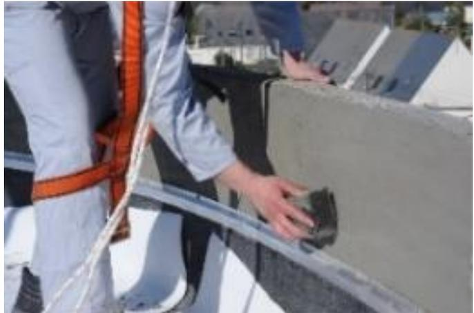
Sin embargo, hay que tener en cuenta que la longitud de anclaje de Sika® CarboDur®-300 Grid es de 200 mm a cada lado de la armadura (refuerzo de flexión).
