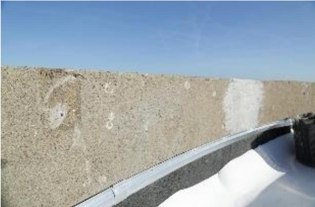
El soporte de hormigón debe estar en buen estado y libre de polvo, materiales sueltos, contaminación superficial y materiales que reduzcan la adherencia.
