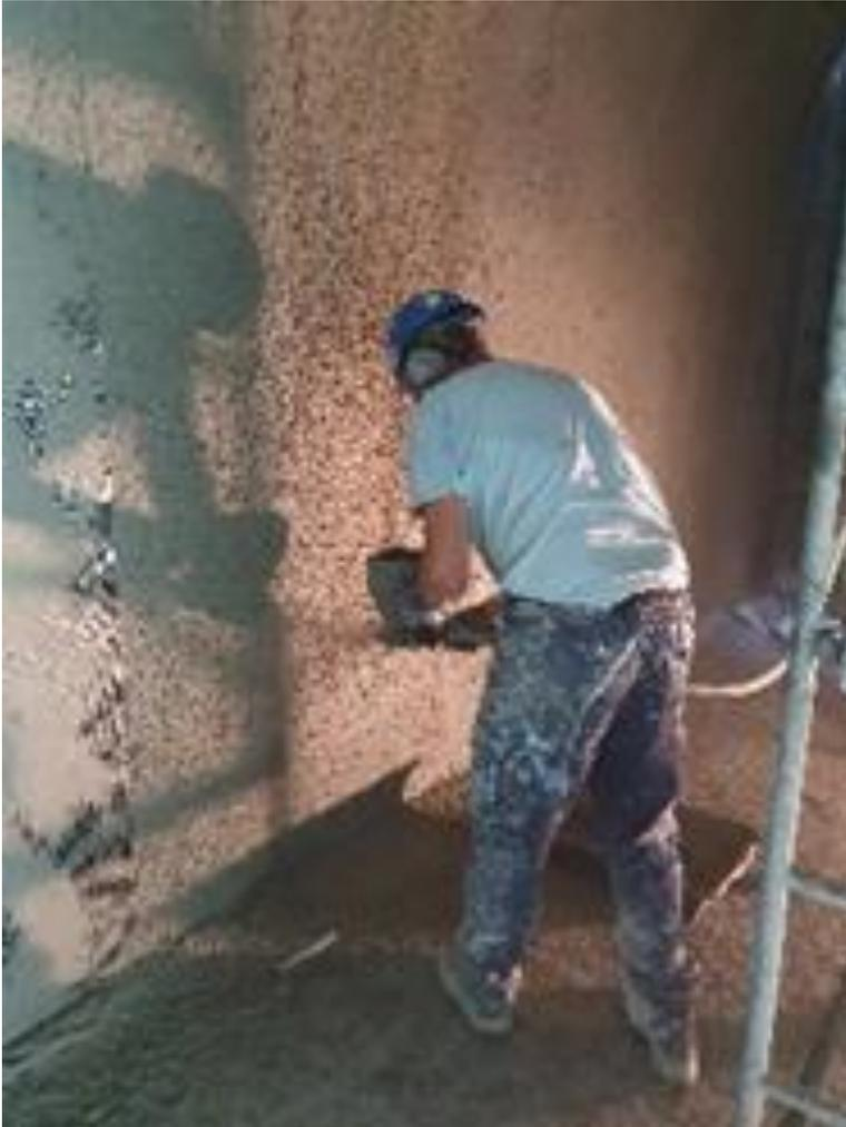
La cantidad premezclada de mortero se introduce en la tolva. El mortero se transporta a un soporte con la ayuda de aire comprimido.
