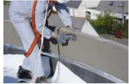
Extender el exceso de Sika MonoTop®-3200 Grid sobre la superficie de la malla hasta obtener una superficie lisa.
