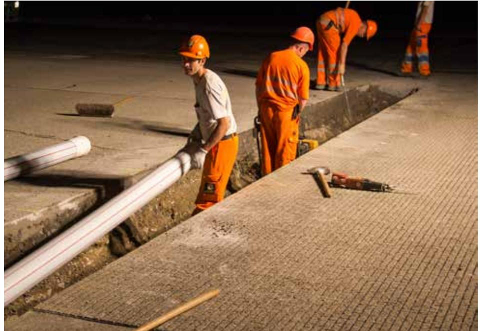
El hormigón tiene que tener la misma altura que la pista de aterrizaje.
