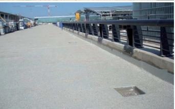
Se trata de la impermeabilización realizada por la empresa PIRSA con el sistema Sikalastic<sup>®</sup> de la parte de los viales horizontales de acceso al Terminal Sur que cubren zonas habitadas o transitadas, aproximadamente 9.000 m² de superficie.
