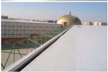
SYTE llevó a cabo la impermeabilización de los más de 30.000 m² de la cubierta de las instalaciones de FIBES (Feria de Muestras Iberoamericanas) en Sevilla con el sistema Sikaplan 12 G.
