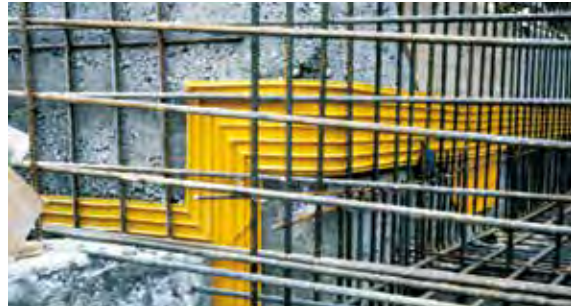
Sika Waterbars son perfiles preconformados de PVC flexibles para las juntas de construcción y de movimiento que pueden someterse tanto a altas como a bajas presiones de agua.
