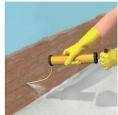
Después de esta operación, los taladros se limpiarán utilizando un compresor de aire.
