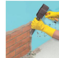
Retirar rodapiés y/o revestimientos/yesos hasta llegar al muro que se va a tratar. Medir el espesor del muro. Si el revestimiento/yeso está contaminado con sales o se encuentra dañado, se tiene que limpiar completamente.
