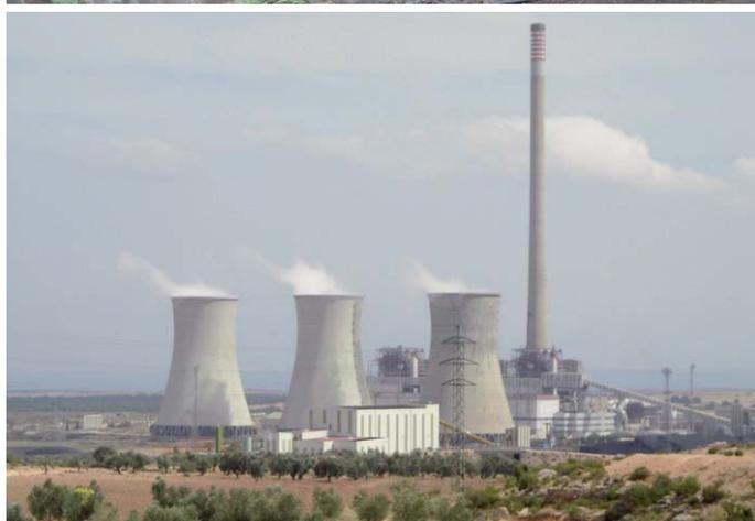
La Unidad de Producción Térmica (UPT) de ENDESA en Andorra (Teruel) está formada por tres grupos. El sistema de disipación del calor del ciclo de vapor en cada grupo se realiza por medio de una torre de refrigeración.
