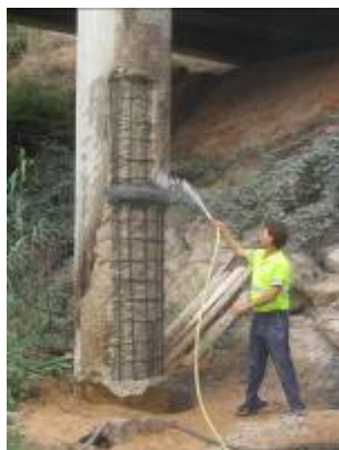
Hidratación del soporte a saturación
