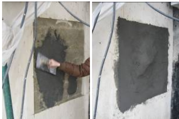
Aplicación de capa fina y a continuación se aplica el espesor necesario
