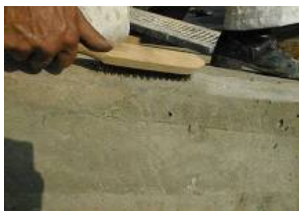
Preparación soporte: cepillado
