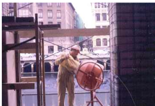
Aplicación mortero mediante la colocación de encofrado
