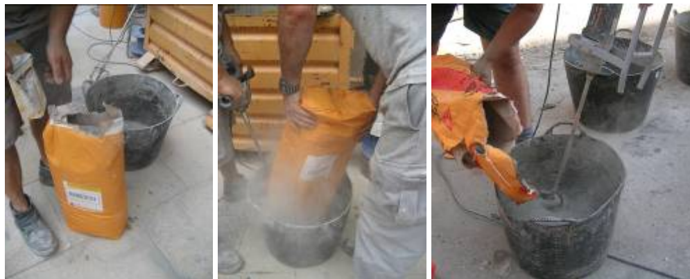
Mezclado con batidora de bajas revoluciones
