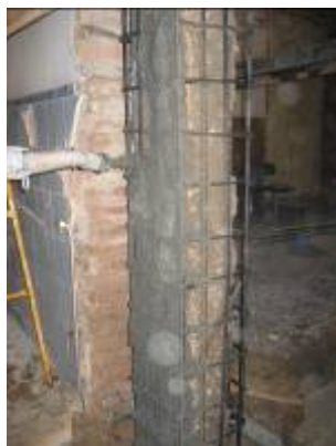
Proyección del mortero
