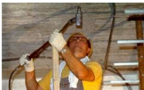
Preparación soporte: Abujardado mecánico
