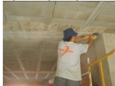
Preparación soporte: lijadora con disco de diamante
