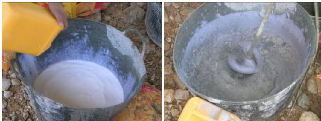
Mezclado productos predosificados – 2 componentes
