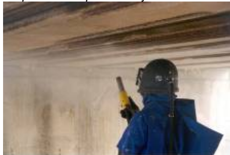
Preparación soporte: chorro de arena
