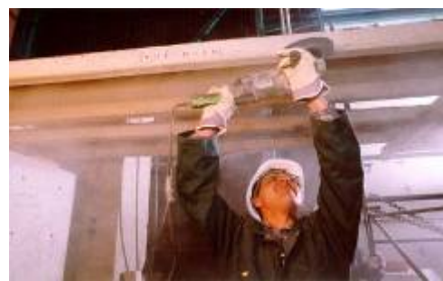
Preparación soporte: limpieza con radial
