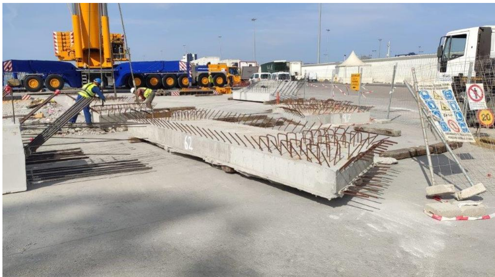
Elementos de hormigón prefabricado tratados con Lanko 761 Steel
