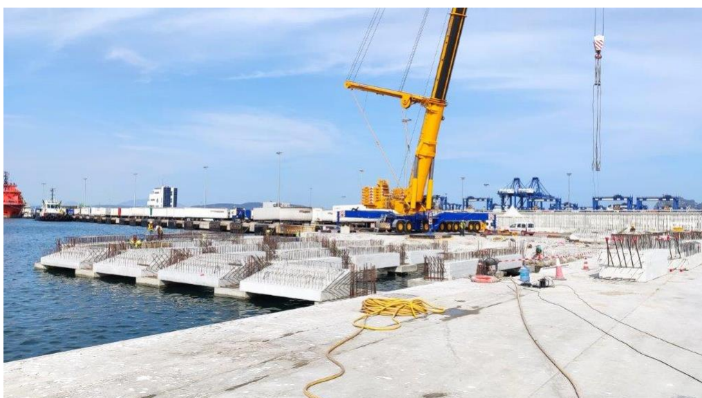
Emplazamiento final de los elementos de hormigón tratados.
