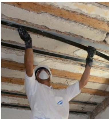
En el caso de esta obra –refuerzo de viguetas de madera en un edificio de viviendas en el casco antiguo de Madrid– Betazul, empresa especialista en este tipo de actuaciones, lleva a cabo un refuerzo por deficiencia a flexión de las vigas con laminados preformados de fibra de carbono Sika CarboDur S
