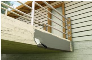
Incremento del recubrimiento de las estructuras de hormigón mediante la adición del mortero
