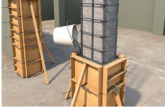
Aumento de la capacidad portante de las estructuras de hormigón mediante la adición de mortero
