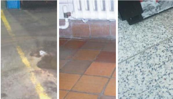
Hay pavimentos que pueden causar multitud de problemas a la hora de ser eliminados para instalar después una nueva superficie: baldosas cerámicas dañadas o mal adheridas, baldosas de amianto, pavimentos sintéticos adheridos, pavimentos muy contaminados, etc.
