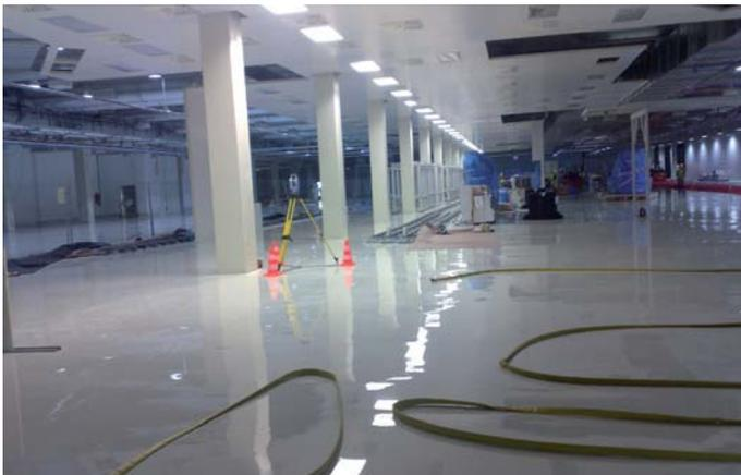
Se lleva a cabo la colocación de un pavimento con alta planimetría en una nueva fábrica de paneles solares de la compañía Gadir Solar. Estas nuevas instalaciones, con una superficie de 14.000 m<sup>2</sup> y una inversión de 9 millones de Euros, exigían un pavimento con una planimetría con una variación de más - menos 1,5 cm en 80 metros lineales.
