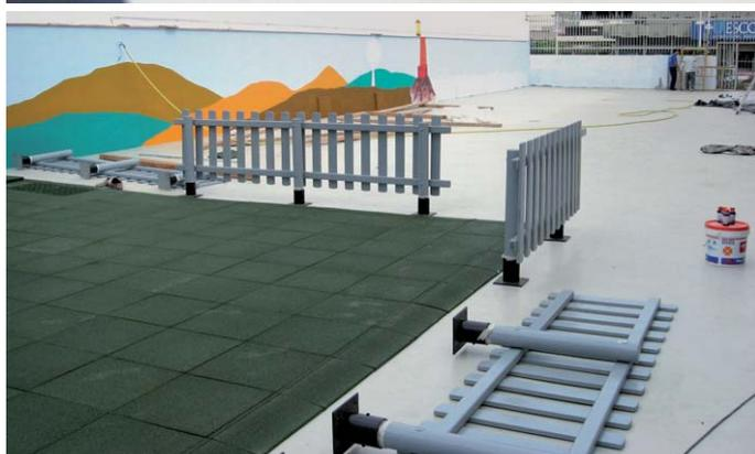
Aplicaciones Químicas Insulares realizó un pavimento en las zonas exteriores de una guardería con el sistema de poliuretano Sikafloor 400 N Elastic, sellado con Sikafloor 400 y Arena Sikadur, que aporta una buena resistencia a la intemperie y una capa antideslizante.
