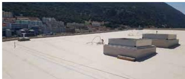
Es muy duradera, pues sus plastificantes no migran, es multicapa e incorpora una malla de fibra de vidrio que le da una gran estabilidad dimensional. Reforzamos el sistema añadiendo una lámina de protección Sarnafil® G445-13 sobre la que se aplicará la cubrición de acabado. En el caso de las cubiertas se añadió como aislamiento paneles de Sarnatherm® G de 85 y 100 mm de espesor según los casos.
