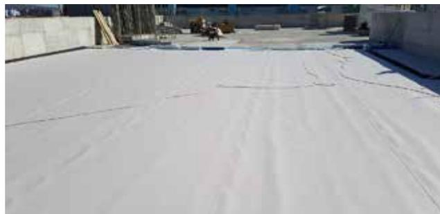
de impermeabilización mediante la lámina Sarnafil® TG 66-18. Esta lámina está indicada para cubiertas invertidas y se integra perfectamente en el conjunto de componentes que forman la cubierta. Está fabricada a partir de poliolefinas flexibles que mantienen sus propiedades incluso a bajas temperaturas. Es muy duradera, pues sus plastificantes no migran, es multicapa e incorpora una malla de fibra de vidrio que le da una gran estabilidad dimensional.
