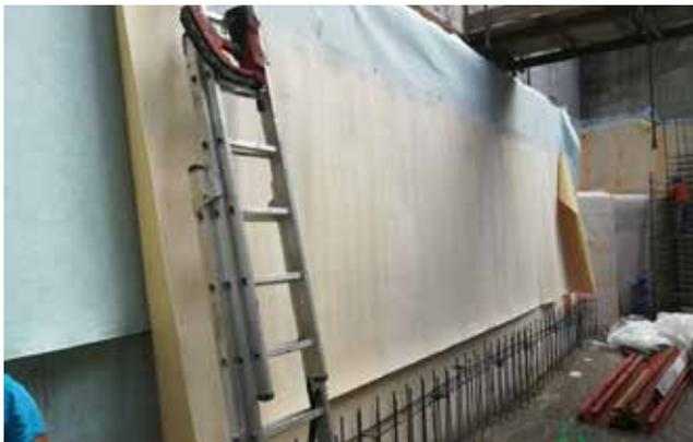
La unión mecánica junto con la malla de sellante previene cualquier flujo lateral de agua entre el sistema de membrana SikaProof® A y el hormigón armado endurecido de la estructura.
