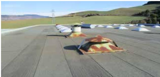
En cubierta, el trabajo se inicia con el cambio de sumideros, instalando prefabricados Sikaplan®.
