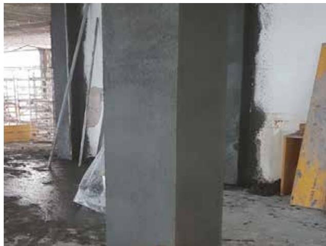
La fibra de carbono elegida para tal efecto es el Sika® CarboDur® S1012 adherida con resina epoxi Sikadur®-30.
