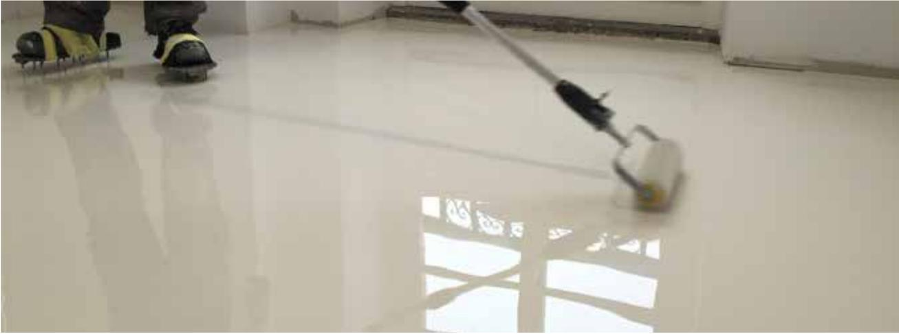
pavimento. Una vez aplicada la capa de imprimación Sikafloor®-161 y antes de 24 horas, procedemos a aplicar la capa principal del todo el sistema, el Sikafloor®-264 blanco.
