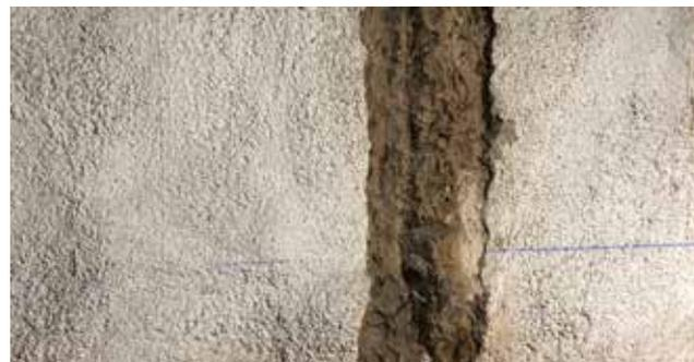
Acabadas las juntas verticales que tenían filtraciones, comenzó a manar agua por el perímetro, a la altura de la losa de cimentación, por lo que hubo que ampliar las actuaciones de inyección en todo el perímetro.
