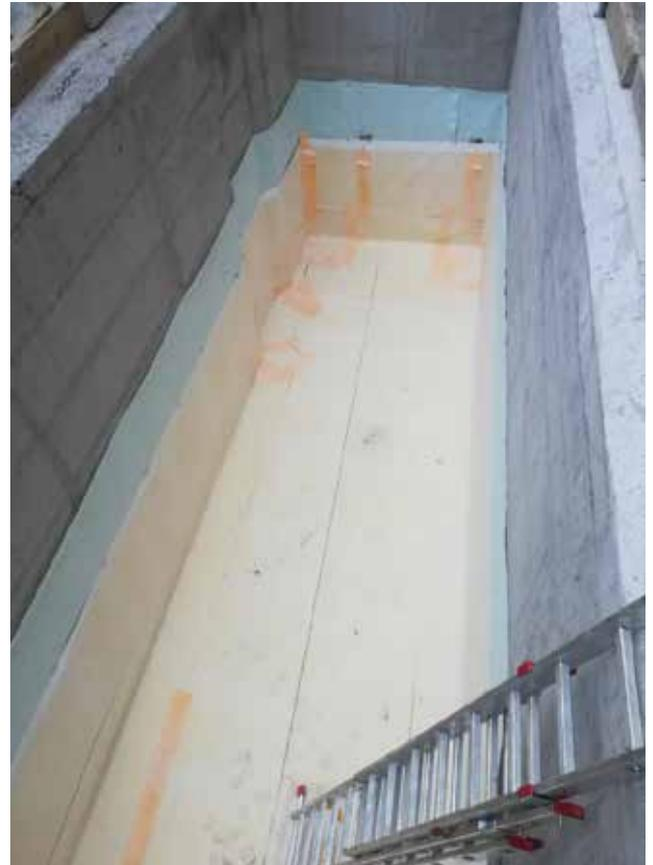
Los motivos de la elección del sistema de impermeabilización con el sistema SikaProof® A es porque está diseñado para su instalación de manera previa a la colocación de la armadura y vertido del hormigón. De esta forma, el hormigón se vierte directamente sobre la membrana SikaProof® A, creando una unión mecánica permanente al incrustarse el hormigón fresco completamente en el geotextil.
