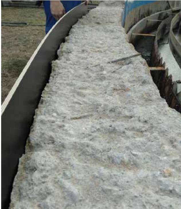
Los trabajos consistieron en una preparación y limpieza del soporte a tratar, aplicación de puente de adherencia y reconstrucción de la sección original con SikaGrout®-334. En los puntos en los que se precisó anclar nueva armadura, dichos anclajes se ejecutaron con adhesión con resina Anchor Fix 3001.
