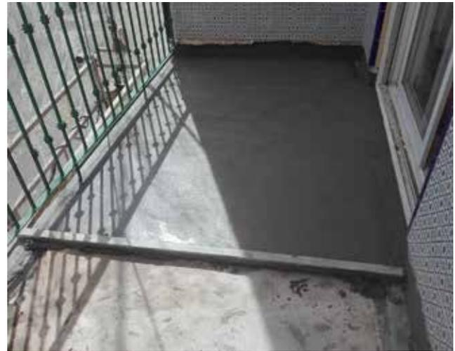
Sika® Reemat Standard + arenado a saturación con Sikadur®-510. Posterior solado con SikaCeram®-201 porcelánico. Juntas perimetrales y cada 4 metros selladas con fondo de junta y SikaHyflex® 250 façade.
