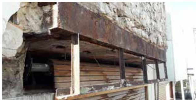
del edificio. Estos dos aparentes detalles sin excesiva importancia y a los que desgraciadamente en general se sigue sin incidir y sin resolver todo lo bien que se debe, han sido los desencadenantes para que el zuncho metálico UPN aumente de volumen por oxidación, haciendo empujar la piedra aplacada en fachada, rompiéndola y provocando una patología generalizada y obligando a acometer una obra descomunal debido a estos pequeños detalles de escaso valor.
