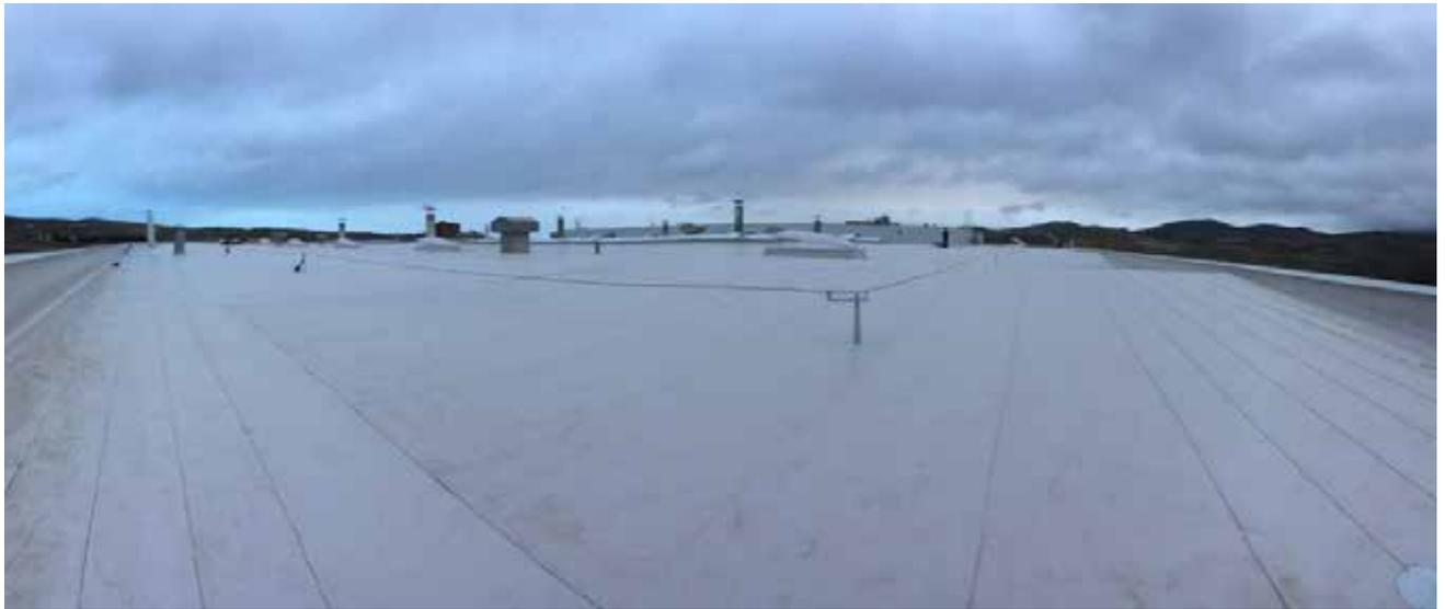
La lana de roca se fija mecánicamente con el número de fijaciones adecuado a base de tornillos y plaquetas. Las uniones de la lámina de FPO, totalmente ecológica y reciclable, se hacen con soldadura de aire caliente que garantizan una total estanqueidad del sistema.
