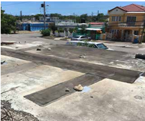
Aspecto de la cubierta antes de la aplicación de la membrana líquida
