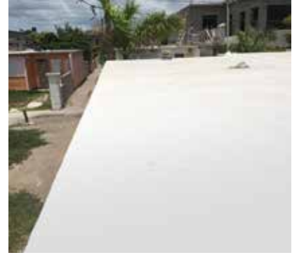
Cubierta acabada con 3 capas de SikaFill®-400.
