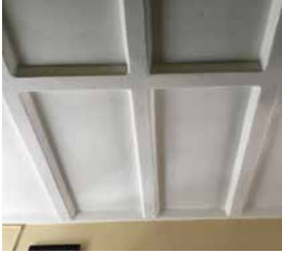
Cara interior de la cubierta
