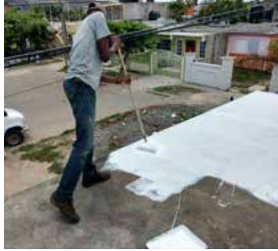
Aplicación del SikaFill®400- diluido con agua al 10% como imprimación
