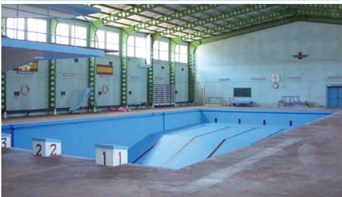
La piscina del Colegio Nuestra Señora de Loreto en Madrid necesita una completa rehabilitación y la aplicación de un revestimiento impermeable en los pavimentos verticales y horizontales.
