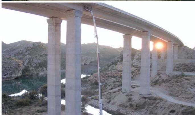
Se le encarga a Betazul la reparación del viaducto de la autovía Alcantarilla - Caravaca a su paso por Mula, Murcia, debiéndose ejecutar trabajos de sellado de fisuras con
