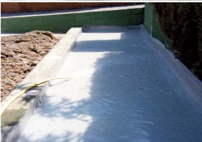
Mundo Vertical recibe el encargo, por filtraciones de agua en el garaje subterráneo de la zona, de realizar las obras de rehabilitación e impermeabilización de 1.300 m<sup>2</sup> de pavimento y de 300 m<sup>2</sup> de jardineras, en la calle Azaleas de la Urbanización "Los Pinos" Situada en la Moraleja de Madrid,
