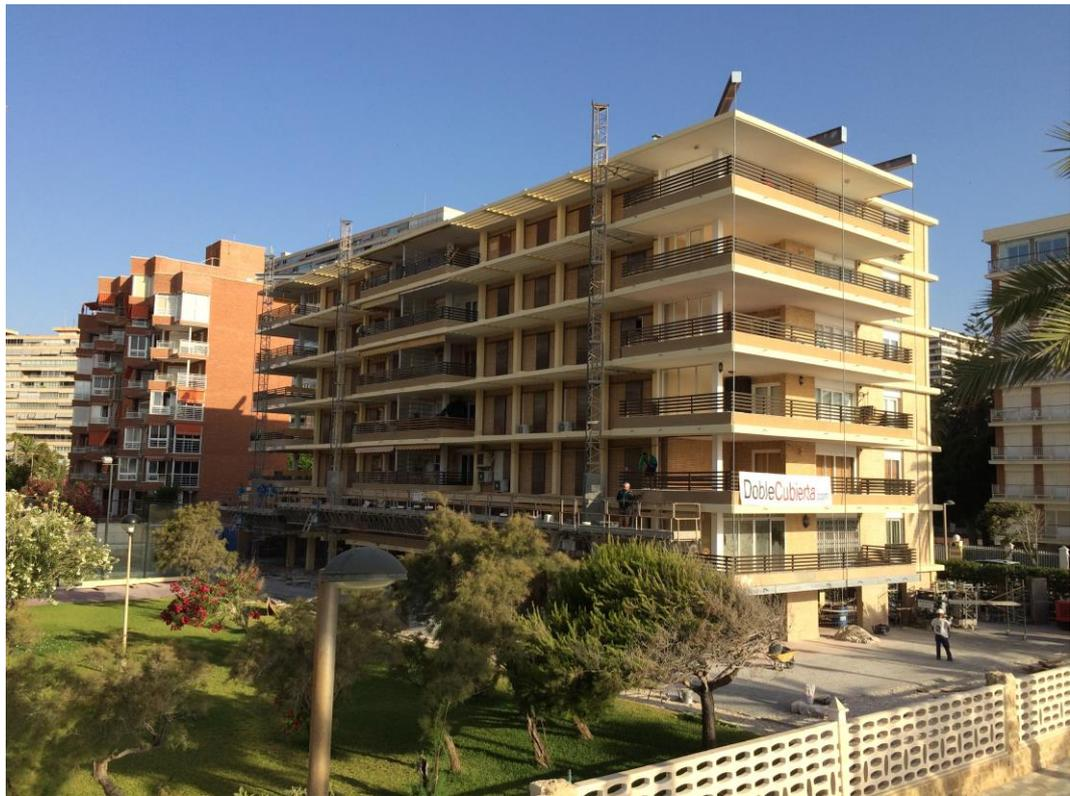
Esta obra consiste en la reparación estructural de un edificio de apartamentos en primera línea de playa construidos en 1962. El proyecto trata principalmente de solucionar tres problemas estructurales bastante importantes que amenazan la habitabilidad del edificio.
