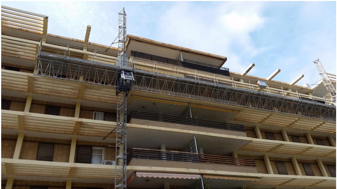
Para ello se ancla una viga metálica UPN galvanizada en caliente en el canto de forjado de los voladizos, posteriormente y gradualmente por plantas se recupera el nivel del voladizo hasta su posición original mediante gatos hidráulicos.
