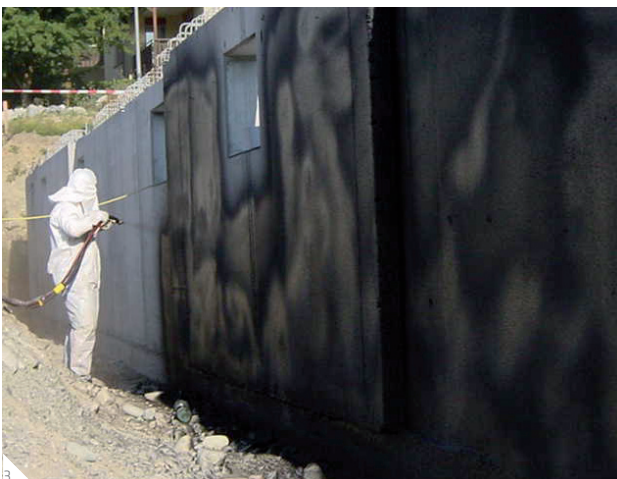
3 Revestimientos bituminosos y membranas
