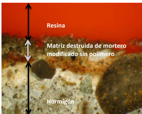
Ilustración 5. Protección con mortero de cemento modificado sin polímero.
