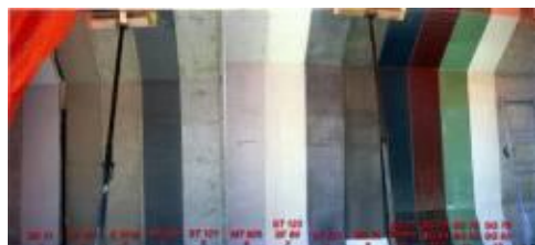
Ilustración 2. Vista inmediata después de aplicar los diversos sistemas de septiembre de 1991
