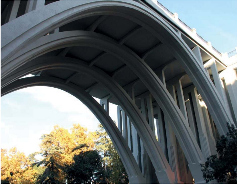
Viaducto de la calle Bailén (Madrid).
