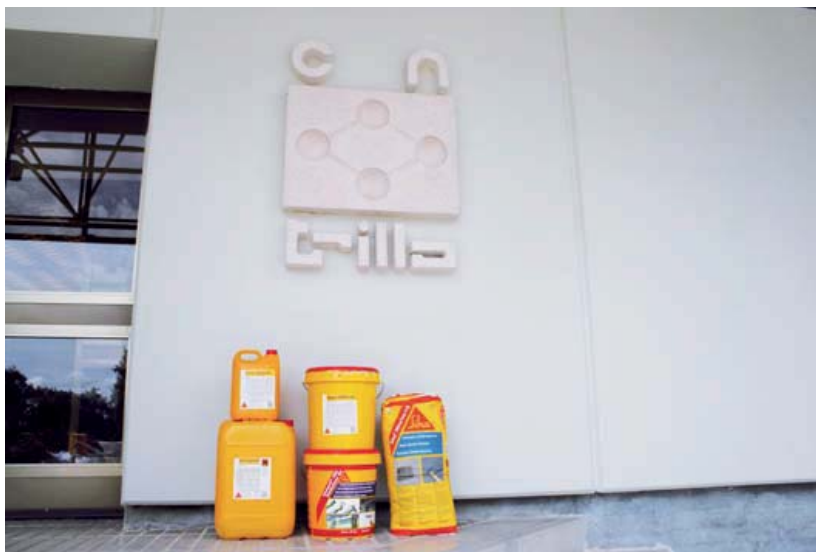
Reparación de la fachada del edificio del centro de información de la Central Nuclear de Trillo.
