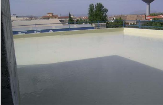
En la impermeabilización de la cubierta de las instalaciones de Metro Ligero de Granada Probasur coloca en primer lugar, y como capa separadora del soporte, el geotextil Sika® Geotex 300 PP, de filamentos continuos de poliéster, con un peso medio de 300 gr/m<sup>2</sup>.
