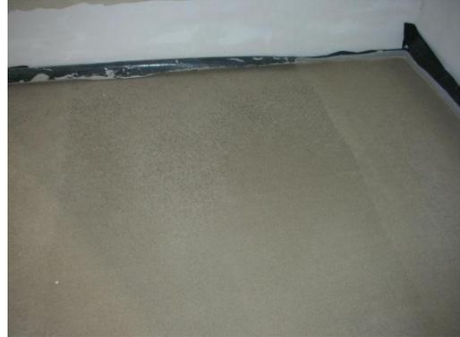
No se aprecia ninguna fisura en el mortero, con lo que la transmisión del calor será uniforme en todas las estancias de la casa, logrando un mayor confort y un menor consumo.
