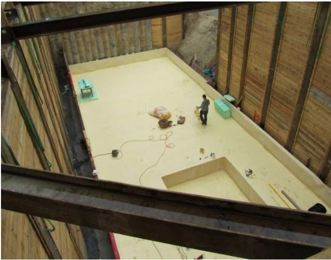
Figura 6. Cimentación impermeabilizada con SikaProof A
