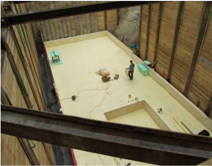
Figura 6. Cimentación impermeabilizada con SikaProof A
