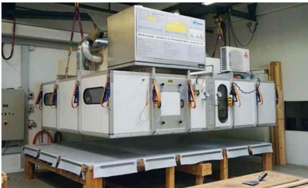
Instalación de prueba de elevación por viento
