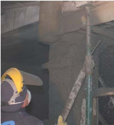
A continuación se lleva a cabo el tratamiento de puente de unión entre el hormigón viejo y el nuevo con Sikadur 32 Fix, adhesivo de dos componentes a base de resinas epoxi, que aplicado sobre superficies de hormigón viejo proporciona una unión perfecta con hormigón fresco.
