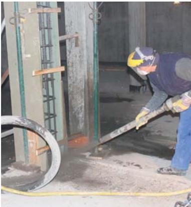
Finalmente se ejecuta la formación del pilar y ménsula mediante la proyección por vía seca de Sikacem Gunita 133, un mortero preparado monocomponente para proyectar por vía seca, a base de cemento, resinas sintéticas y humo de sílice.
