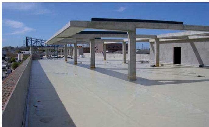
Opteimsa hubo de impermeabilizar la cubierta general de 1.500 m<sup>2</sup>, de la empresa Alcobendas Logística en la calle Aragoneses de Alcobendas. Este trabajo se ejecutó con el sistema de PVC, Sikaplan® 15 G
