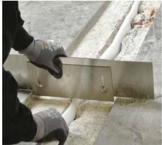
Ajuste de la altura del fondo de junta con una llana ajustable
