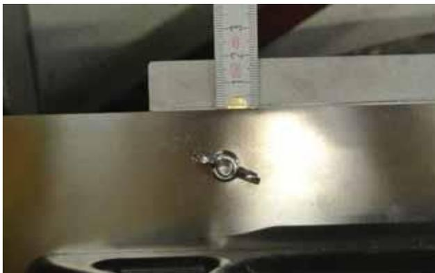
Distribución de Sikadur-31+ en el corte mediante el uso de la llana ajustable para distribuir el adhesivo.
