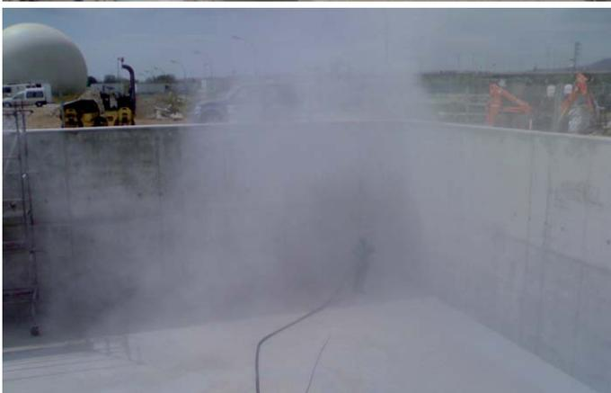
Pintura Industrial Reus (Pirsa) realizó trabajos de revestimiento en las paredes interiores y de construcción de medias cañas en el depósito de hormigón de la EDAR de San Feliu de Llobregat en Barcelona.
