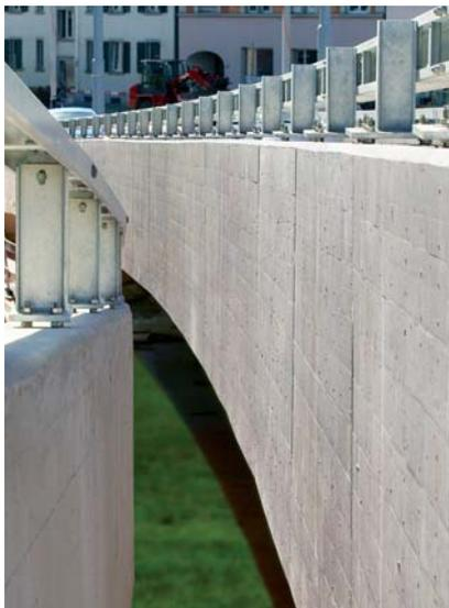
Protección con barra de acero embebida sin cambiar la apariencia del hormigón.
