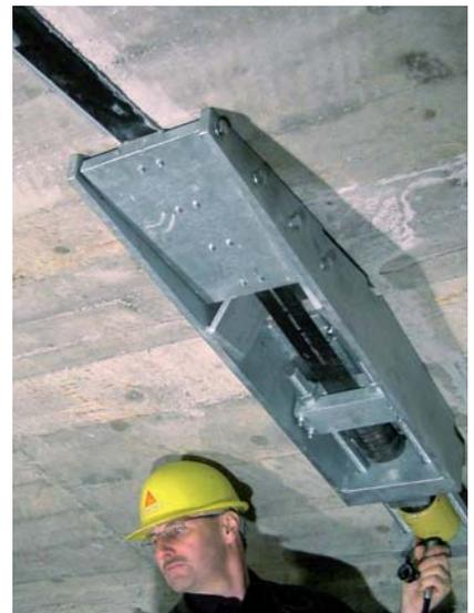
Para un refuerzo estructural de alta eficiencia de los puentes de hormigón armado.
