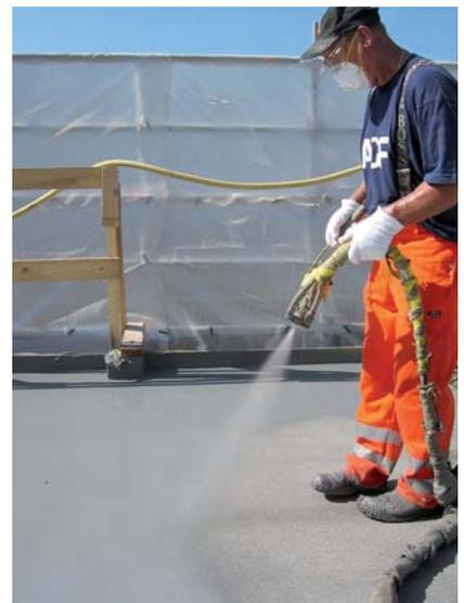
Protección duradera para punteo de fisuras en los tableros.
