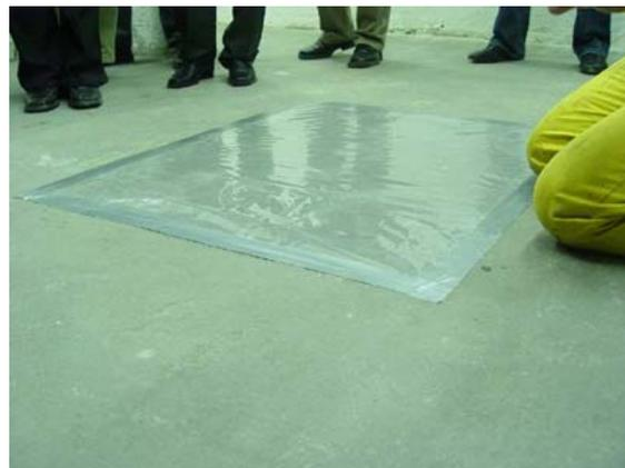
Antes de la aplicación, compruebe el contenido de humedad del soporte, la humedad relativa del aire y el punto de rocío.
