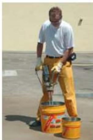
Mezcle ambos componentes completamente con una batidora eléctrica de bajas revoluciones (300 -400 rpm).
