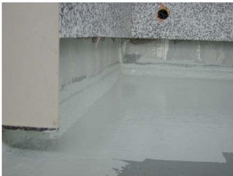
Espolvorear hasta saturación sobre la capa fresca de Sikafloor-Colour Chips Mix, por ejemplo Gobi, con un consumo aproximado de 1 kg/m<sup>2</sup>.
