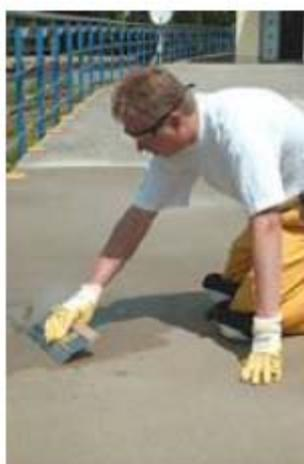
Aplicación de la capa de nivelación con una rastra/llana hasta el espesor necesario- de rodillas o...
