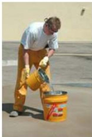
Antes del mezclado, remover el componente A (resina) y añadir todo el componente B (endurecedor).
