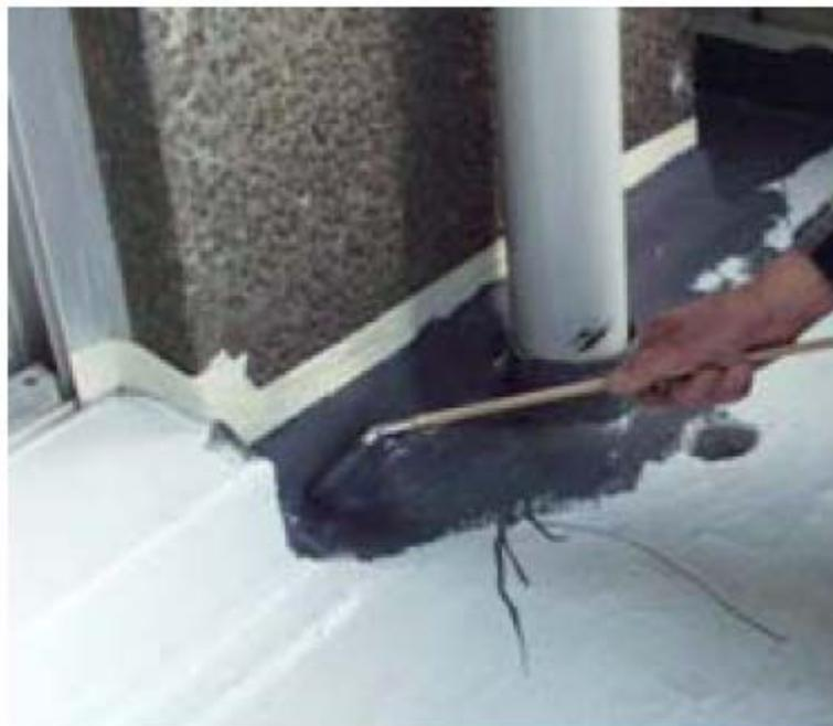
**Espesor de película seca mínimo del Sikafloor®-405 con el Sika Reemat Premium: 1400 µm;**
