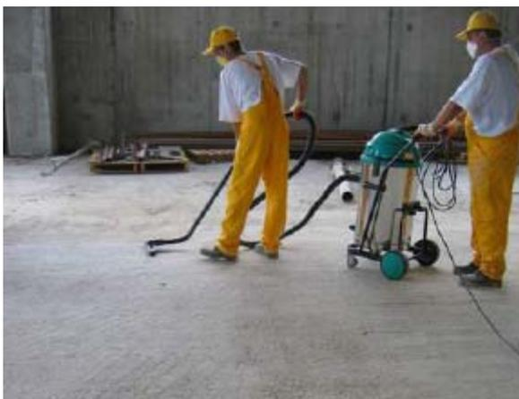
El hormigón débil se debe eliminar y se deben dejar vistos todos los defectos superficiales como coqueras y nidos de grava.
