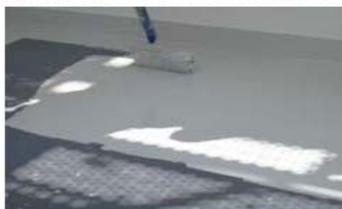
Sikafloor®-405/ Decothane Balcons Ligante de resina de poliuretano en base disolvente de reacción activada por la humedad, pigmentada, monocomponente, altamente elástica, resistente a los rayos UV
