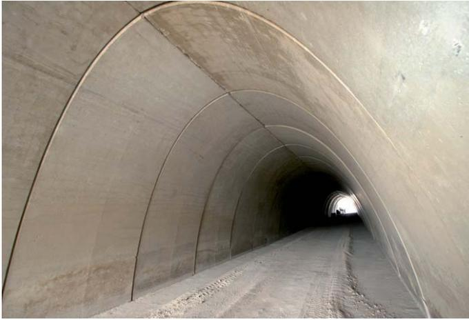
Betazul hubo de ejecutar en esta ocasión trabajos de refuerzo de la bóveda prefabricada de hormigón armado mediante el recrecido interior continuo, con mortero proyectado de un espesor variable, con un desarrollo de la bóveda de 11,50 m.
