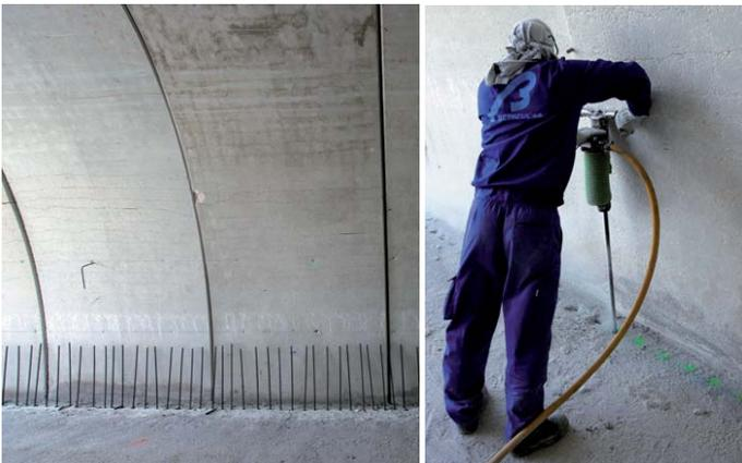
A continuación se realizaron, mediante Sika AnchorFix 2, los anclajes para la armadura principal en taladros de 400 mm de profundidad. Como puente de adherencia se utilizó Sikadur 32 FIX.
