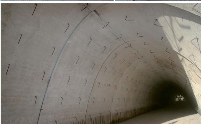
La armadura del recubrimiento se dispuso en la cara interior.
