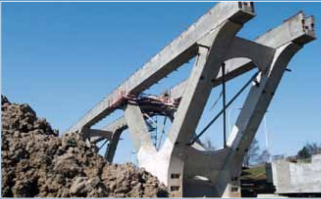
Viaducto entre Herve y Battice, Belgica
