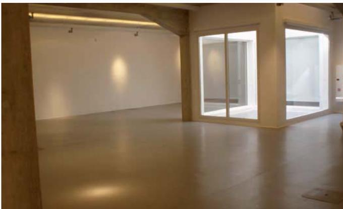
Se aplicó entonces el Sikafloor® 81 EpoCem con 3 mm de espesor y la pintura Sikafloor® 357 en el RAL 7030 en dos manos. Finalmente, se selló el pavimento con una mano de Sikafloor® 356 SP en satinado.
