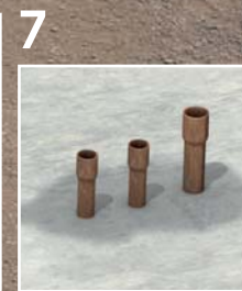
Filtraciones en Penetraciones (ej. tuberías)
