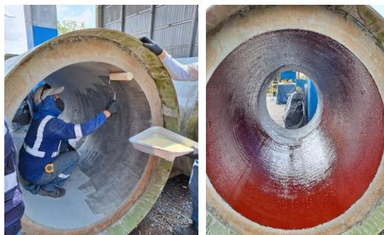
**Tubería en fase de revestimiento manual de Sikagard®-7000 CR**
