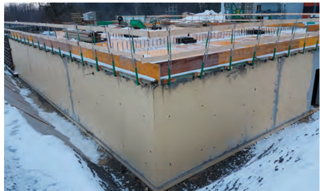
Muros a dos caras con SikaProof® A+: tras retirar el encofrado, hay que sellar todas las penetraciones de los anclajes.
