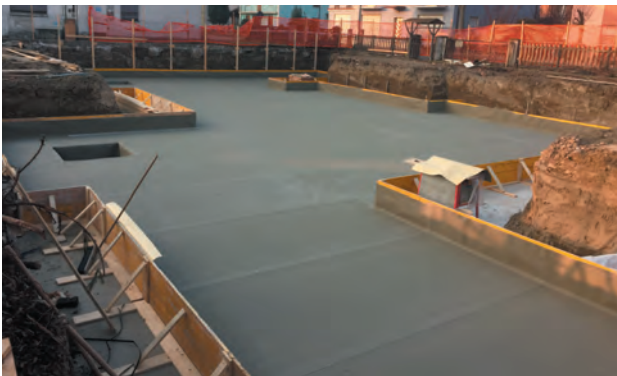
Aplicación habitual del SikaProof® A+ para la losa de cimentación.
