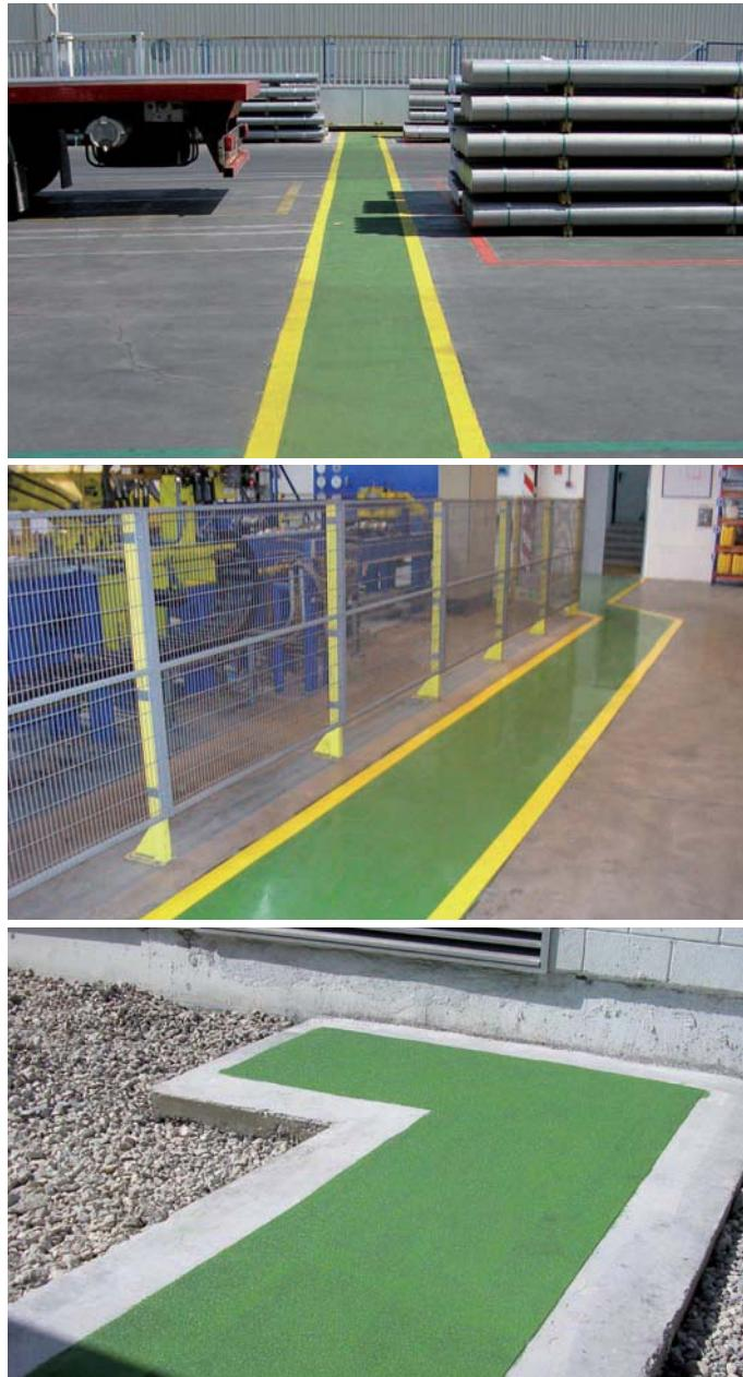
Opteimsa ejecutó 455 m<sup>2</sup> de pavimento a base de resinas epoxi en el pasillo técnico del interior de una nave industrial. El revestimiento, en una zona dispuesta para mantenimiento y tránsito de seguridad, se llevó a cabo mediante un sistema de mortero epoxi coloreado de baja viscosidad Sikafloor® 261.
