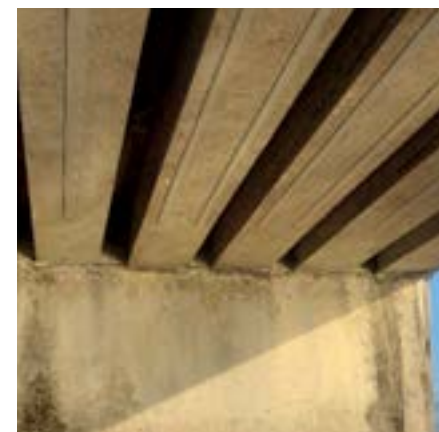
La parte inferior de la vigas presenta un buen aspecto. Salvo en alguna zona muy puntual, el aspecto en todas las vigas como en la foto.
